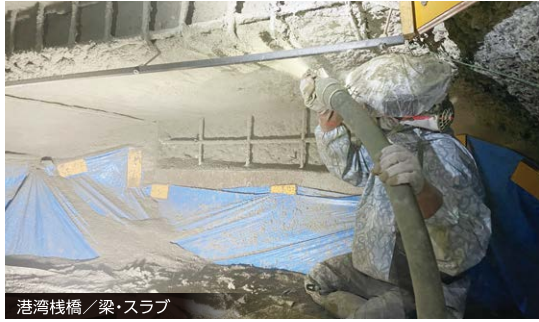
港湾栈橋／梁・スラブ
