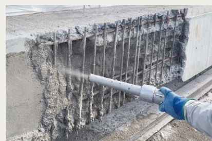
エアショットワンの吹付状況
