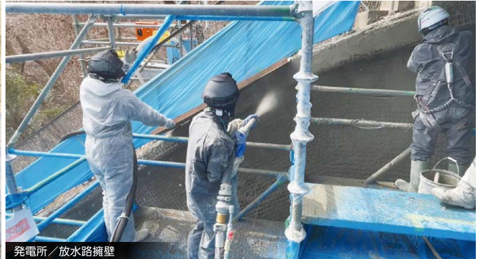
発電所／放水路擁壁
